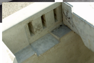
側溝蓋掛り部
