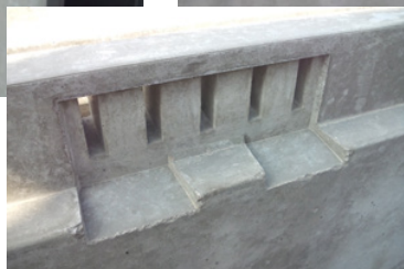
側溝蓋掛り部
