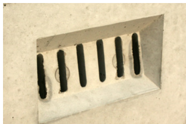
通水孔部:外側
