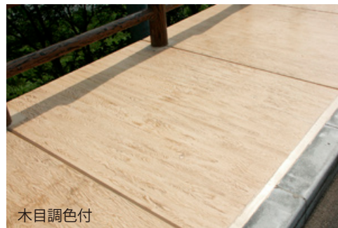
張り出し歩道
