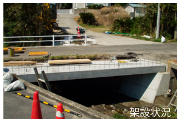
車道拡幅工事
